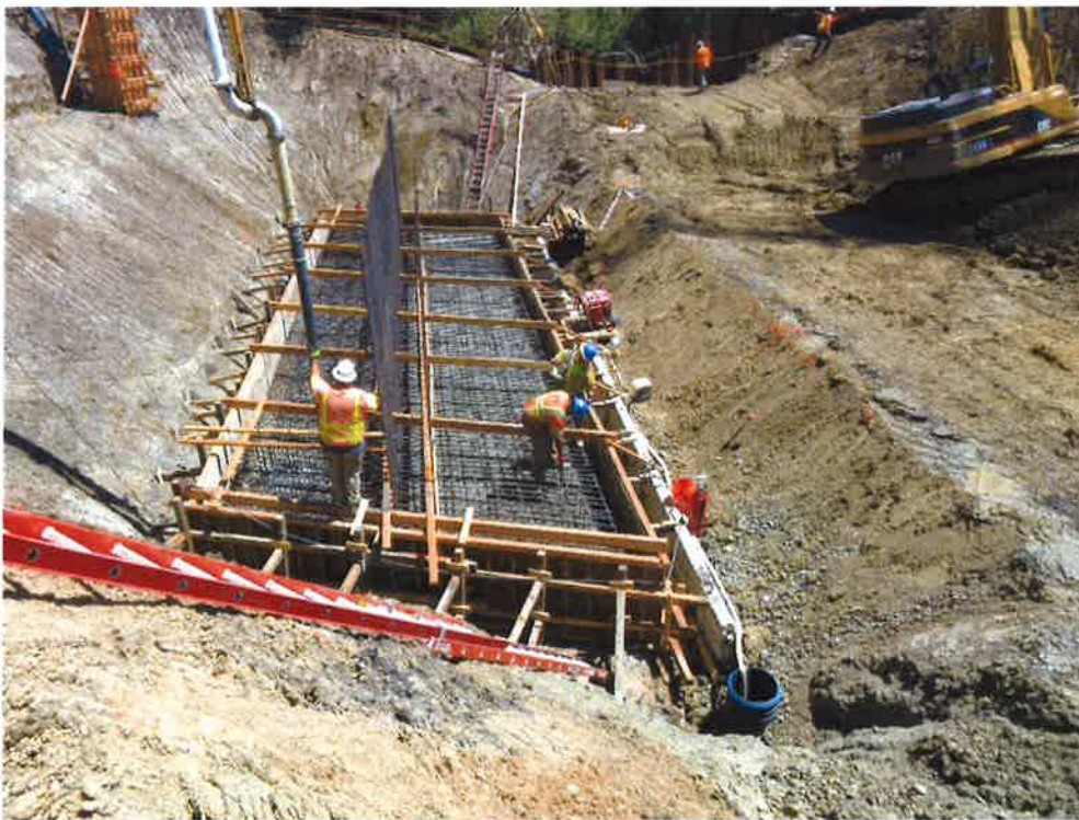
Abut. 2 footing pour.
