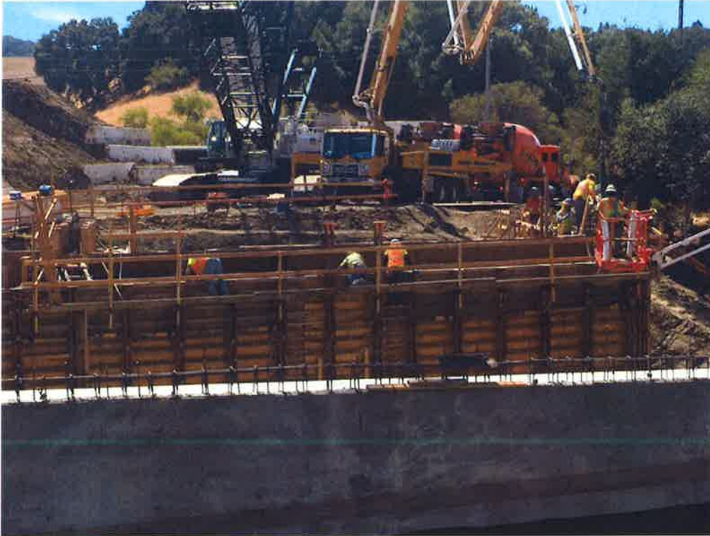
Abutment 1 stem pour.
